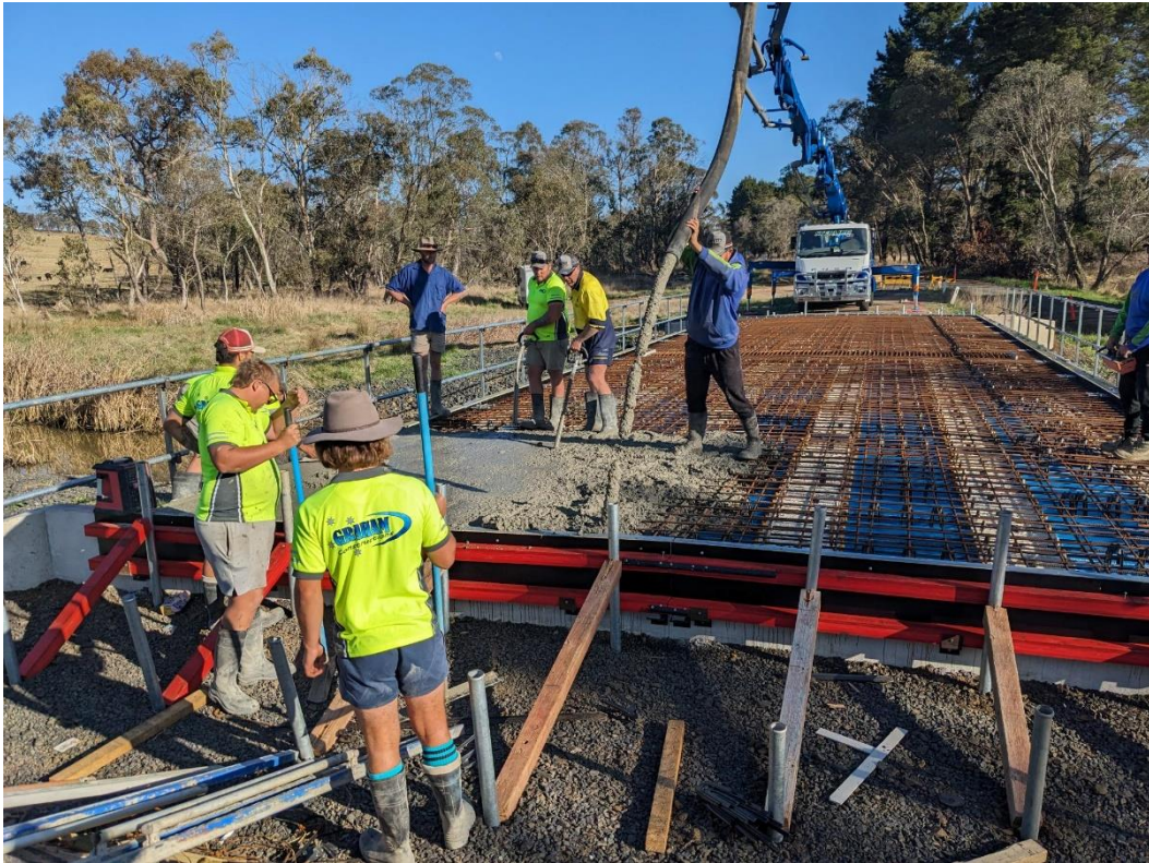
Image 1: Yarrow Creek deck pour
