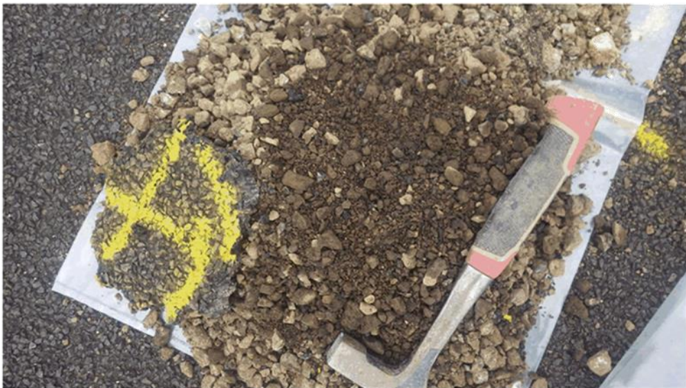
BH03 – Granular base layer
