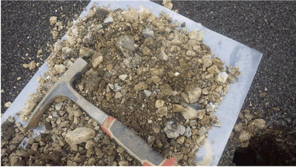
BH03 – Granular subbase layer
